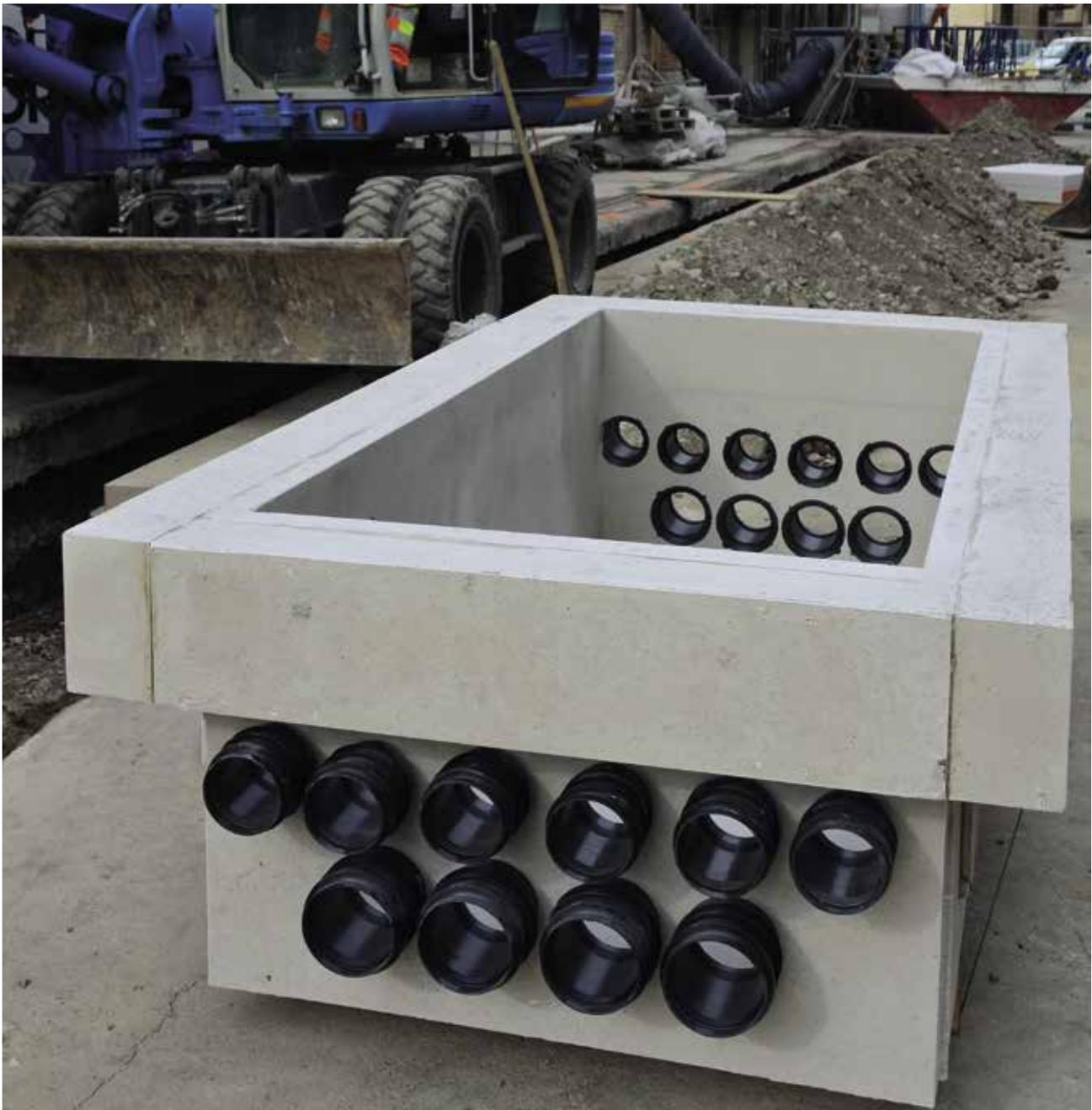
In einem Industrieareal erfolgt die Erneuerung der Kabelkanalisation. ACO Standardschächte mit individueller Gestaltung der Kabeleinführungen ermöglichen eine schnelle Abwicklung.
