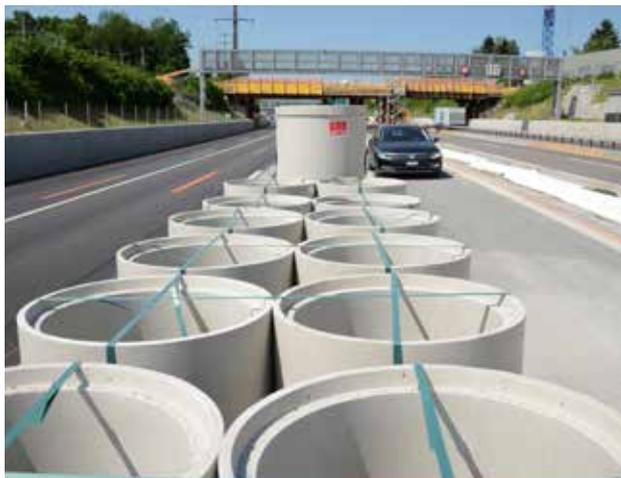
Schlammsammler in einem Zug versetzen, anschliessen und fertig. Mit dem Komplettschachtsystem von ACO werden Schlammsammler in einem Stück gefertigt. Alle benötigten Anschlüsse werden vorgefertigt und mit integrierter Dichtung geliefert. Sehr grosse Ein- und Ausläufe sind ohne Probleme möglich, auch Anschlüsse für grosse Leitungsfälle können produziert werden.
