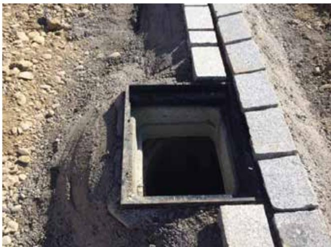
Anfangen vom Aufsetzen des Betonsockels auf den Schacht oder Schlammsammler bis zu den Steinarbeiten vereinfacht der Betonsockel Typ 7 "Spresa" die Arbeitsschritte und spart Zeit und Kosten.
